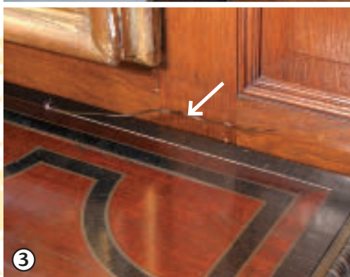
1 Behang is beschadigd door vochtig reinigen van aangrenzend houtwerk 2 Zand en opgehoopt vuil hebben de vloertegels onder de loper ernstig beschadigd 3 Door gebruik van plumeaus en stofdoeken kunnen fineer en andere ingelegde materialen loslaten 4 Veeg- en schrobmachines brengen vaak veel schade toe
